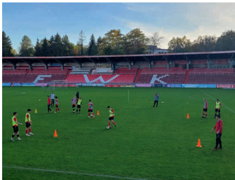
Praxisdemonstration in der FLYERALARM ARENA in Würzburg unter der Leitung von Marco Wildersinn
